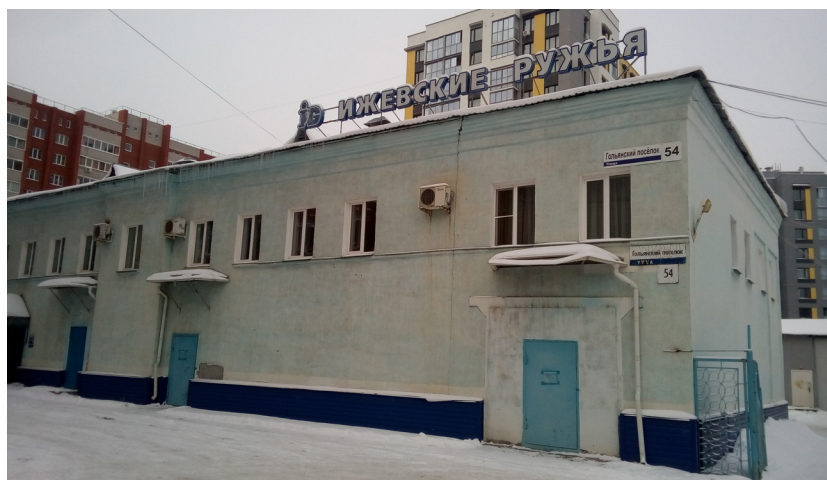
Фото 7. Здание бывшего детского сада завода № 622
